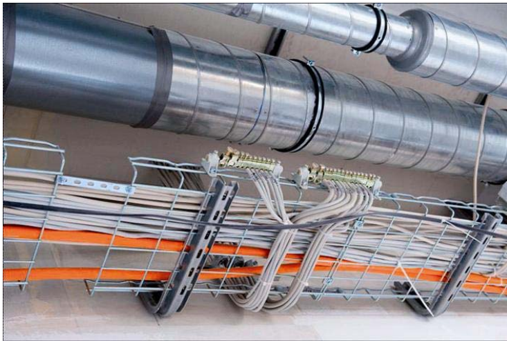
Bild 3: Auch Verlegung und Schutz von nL-Leitungen sollten mit der erforderlichen Sorgfalt erfolgen
