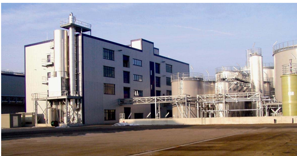
Bild 1: Verbio Diesel Schwedt – eine Prozessanlage für Biodiesel mit 100% PROFIBUS
