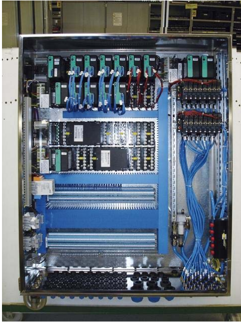
Bild 3: Remote I/O als intelligenter Verteilerkasten
